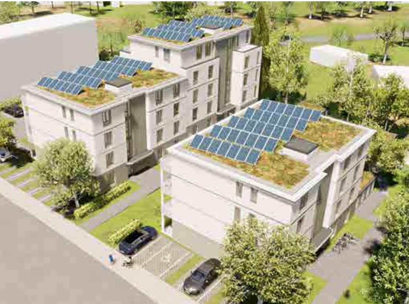
Das Bauprojekt „Thaers Quartier“ kombiniert Holz und Stahlbeton. Holz wird dabei für Fassaden und Wände verwendet; die Decken können als Spannbetonkonstruktionen filigraner und somit platzsparender ausgeführt werden als mit Massivholz. Nicht fehlen darf eine zeitgemäße Nutzung der Dächer für Photovoltaik und extensive Begrünung
